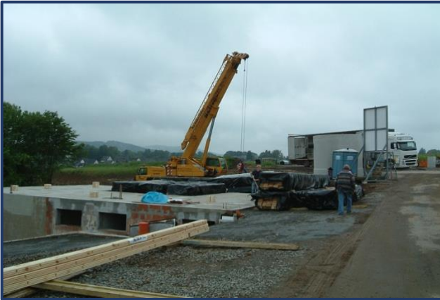
1. Tag: Anlieferung – Entladung auf Baustelle
