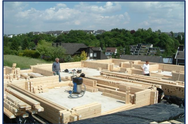
2. Tag: Aufbau Balken für Balken
